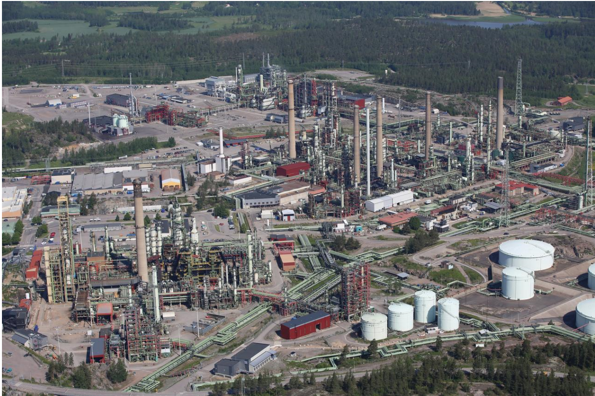
Abbildung 4: Neste's Porvoo refinery in Finland, NEXBTL facilities, Neste (Bild: Neste Oyj, www.neste.com )
