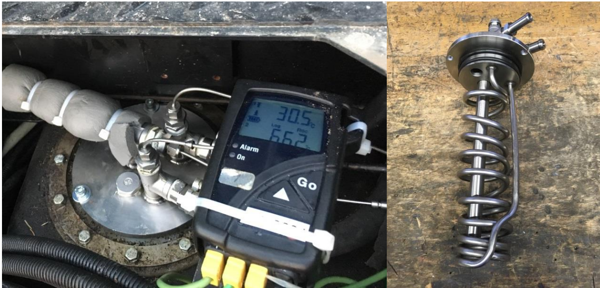
Abbildung 11: Modifizierter Tankgeber der 2. Generation im ausgebauten Zustand (rechts) sowie im eingebauten Zustand mit Datenlogger für die Erfassung von Kühlmittel- und Kraftstofftemperaturen (links)
