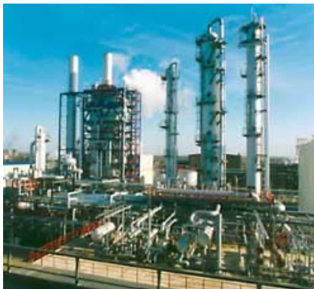
Abb. 4: SVZ-Anlage für die Herstellung von Methanol aus organischen Abfällen und Kohle
