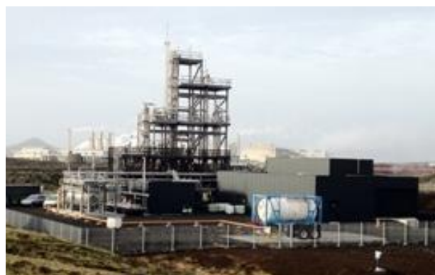
Abbildung: Strom-zu-Methanol Anlage „George Olah“ in Grindavik, Reykjavik, Island (Foto: CRI)
